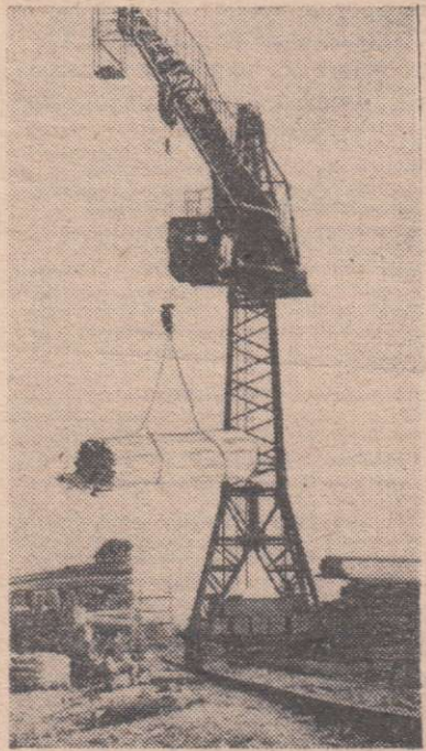
На снимке: погрузка пиломатериалов на нижнем складе Дзержинского леспромхоза. Работает козловый консольный кран.
